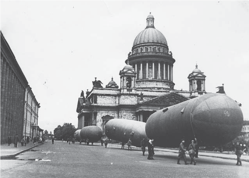
Газгольдеры на Исаакиевской площади
